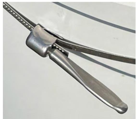
Abbildung 22: Befestigung Vogelschutzring
